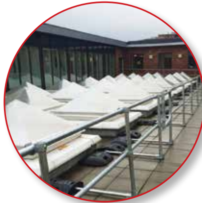
Roof Edge Protection
